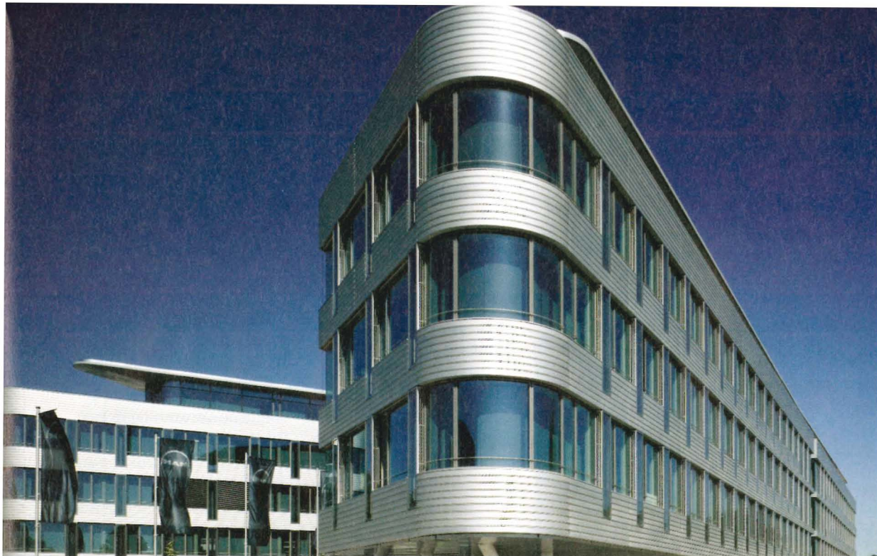
Glanzvoll: die Fassaden der MAN-Hauptverwaltung
